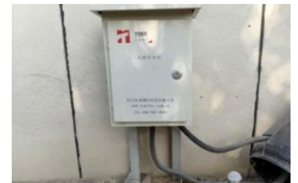
江西亚东矿区实行全天候实时监测爆破振动
