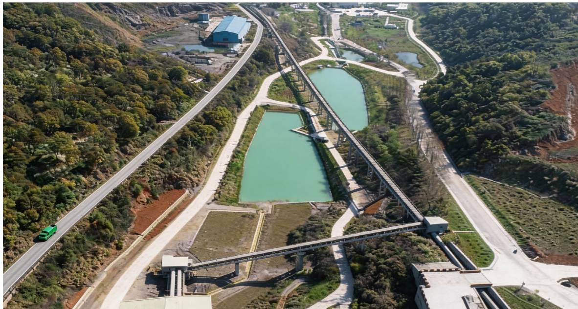
江西亚东四级沉淀池
