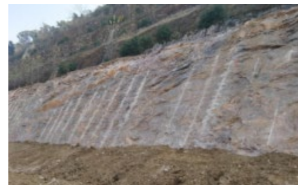
江西亚东矿区终了边坡实施预裂爆破,维持岩体完整及稳定性
