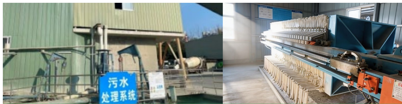
公司下辖的各水泥制品公司积极践行水资源回收利用措施，将生产水泥混凝土及清洗搅拌车的废水经过压滤机除泥后回收利用来作为混凝土生产用水，压滤得泥饼送交水泥厂作为水泥生产原料，做到废水零排放。
